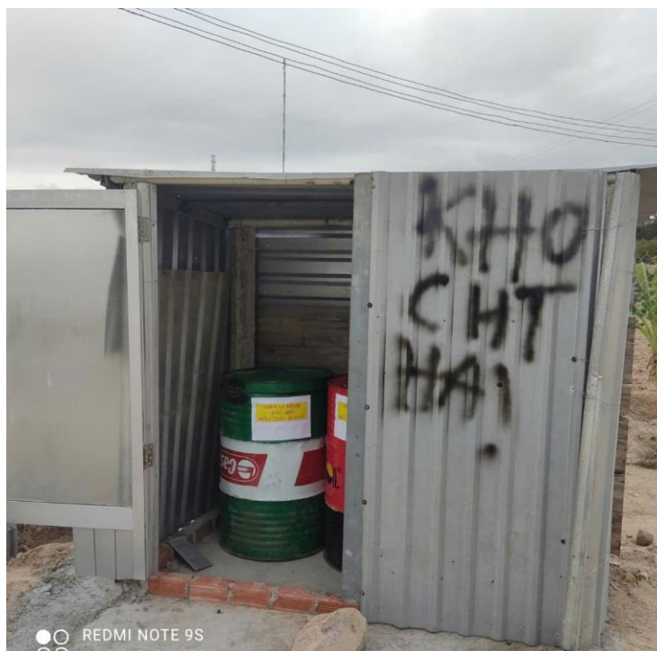
Hình 3.3. Kho chứa CTNH tại cơ sở
